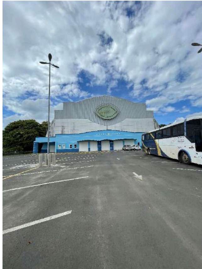
Figura 6-30 - Vista diurna do Ginásio Municipal Agostinho Zarpellon
