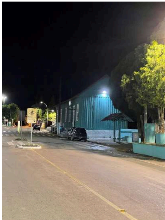
Figura 6-35 - Vista noturna da Antiga estação de trem
