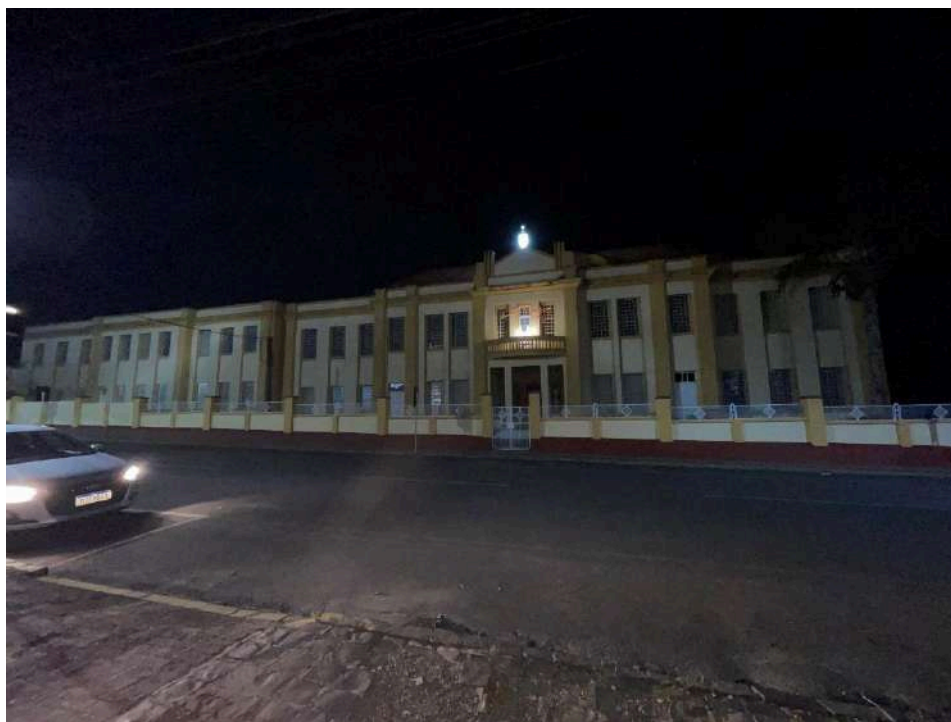
Figura 6-24 - Vista noturna do Colégio Nossa Senhora das Graças
