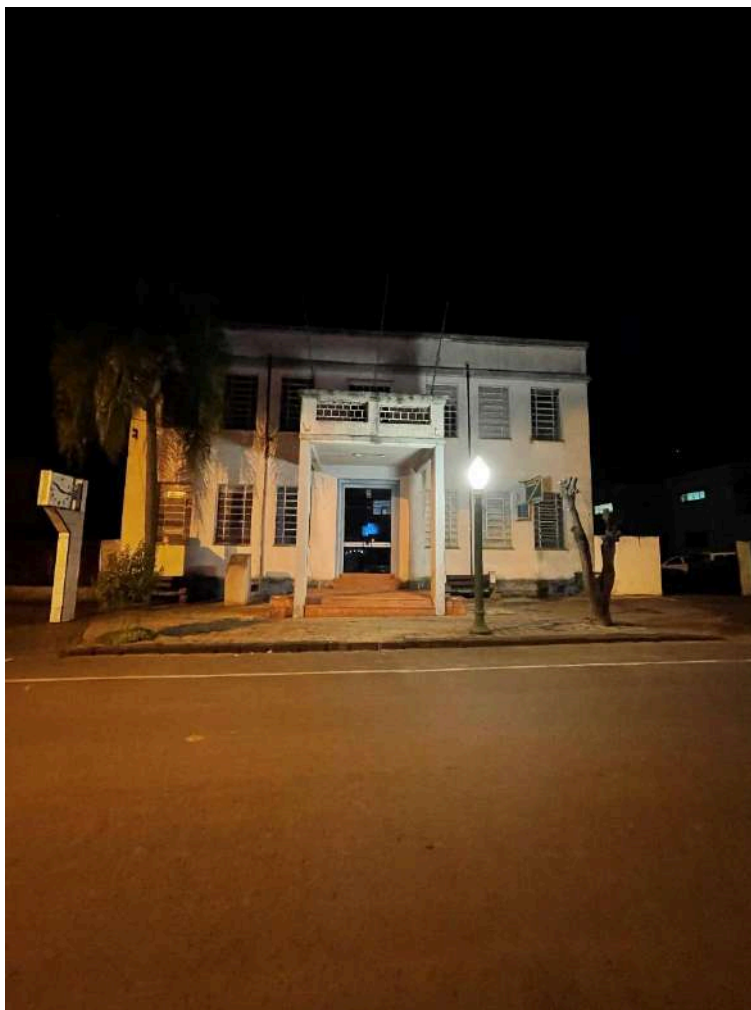
Figura 6-17 - Vista noturna do Paço Municipal
