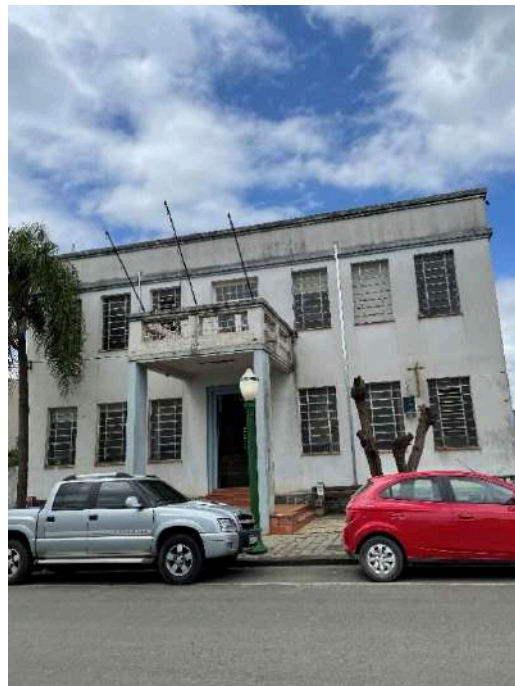
Figura 6-16 - Vista diurna do Paço Municipal
