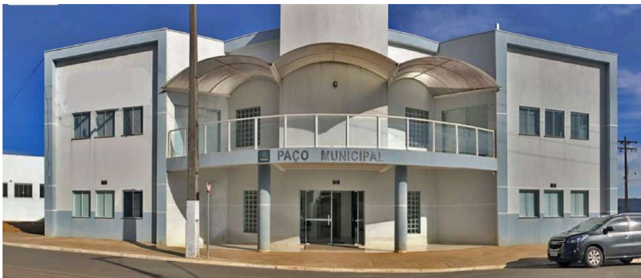
Figura 6-8 - Vista diurna do Paço Municipal
