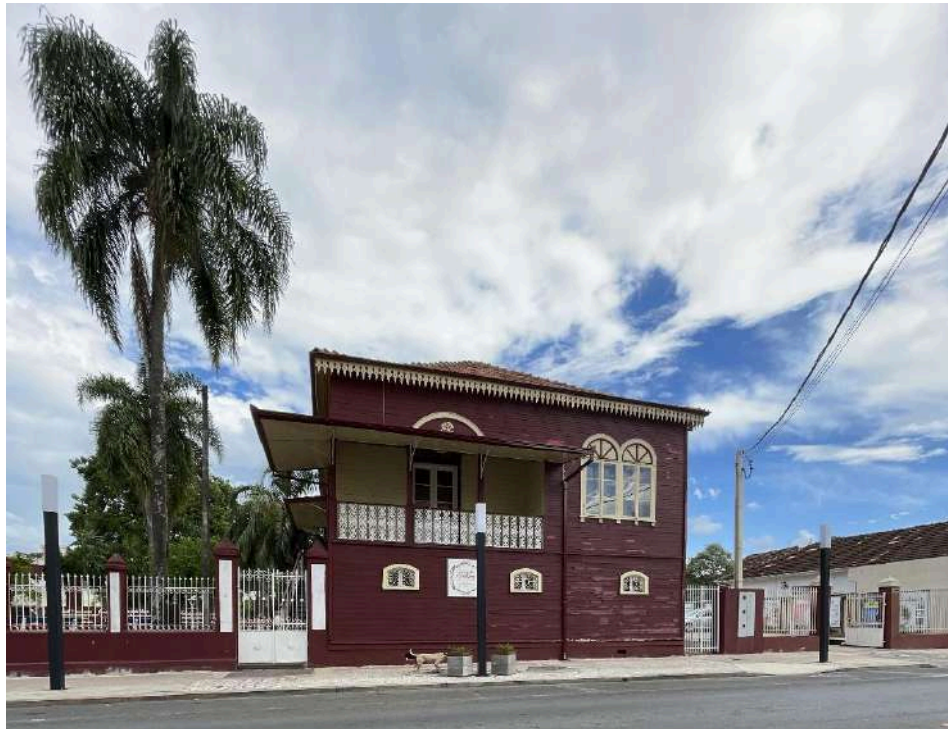
Figura 6-18 - Vista diurna da Casa de Cultura
