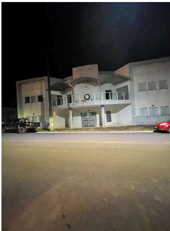
Figura 6-9 - Vista noturna do Paço Municipal
