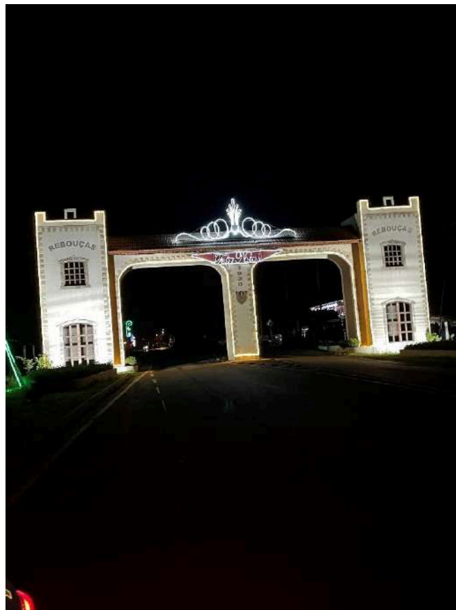
Figura 6-15 - Vista noturna do Pórtico de entrada em Rebouças
